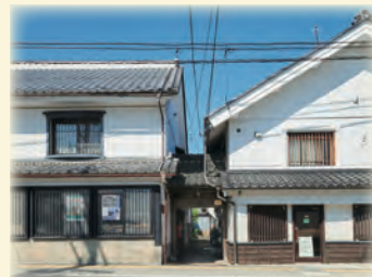
店舗の横に設けられた脇門
